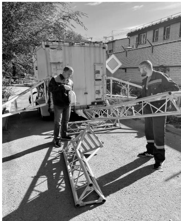
Рисунок 1. Сборка мачты
